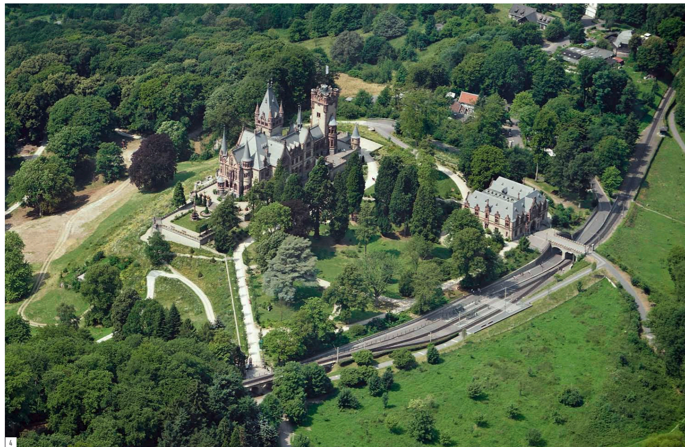
ABB.4 Die neugestaltete Mittelstation der Drachenfelsbahn verbindet den historischen Zugang zum Ensemble Schloss Drachenburg mit der Haupttourismusachse am Drachenfels.
